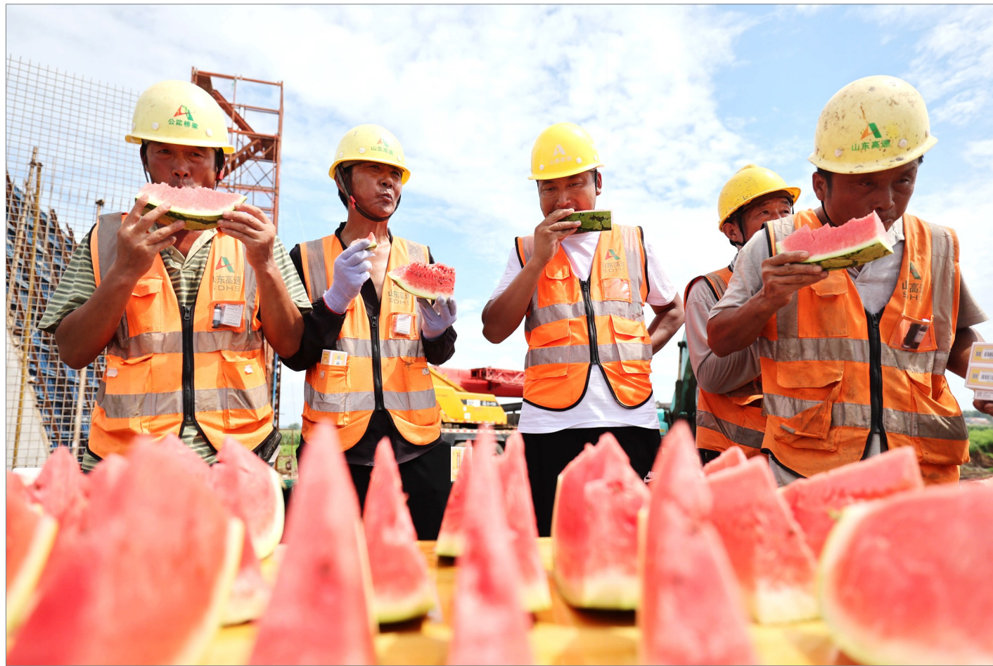
八月六日，在山东省临沂市沂南县铜井镇董梁高速第四标段施工现场，工人们休息时吃西瓜消暑。近日，多地持续高温天气，各地积极开展送西瓜、送防暑药物等关爱活动，确保高温下户外劳动者的安全。
