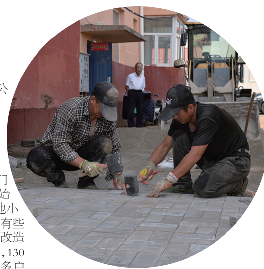
工人对小区路面进行硬化
