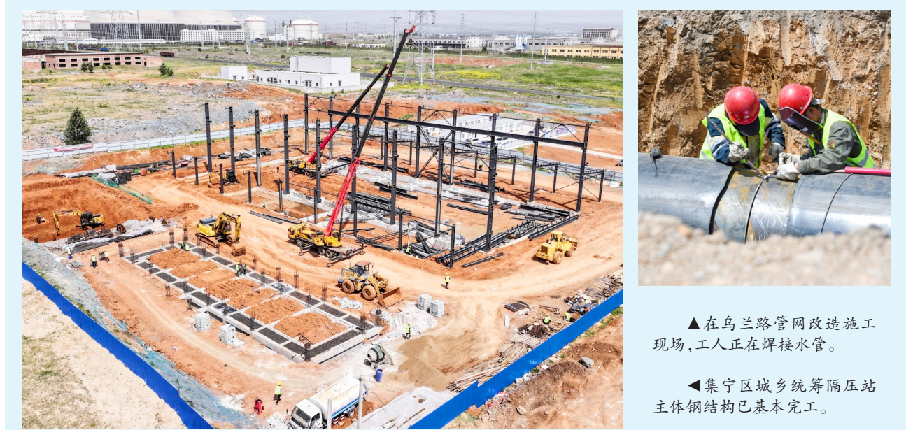
▲在乌兰路管网改造施工现场,工人正在焊接水管。 ▲集宁区城乡统筹隔压站主体钢结构已基本完工。
