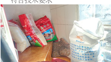
通往二楼疏散通道堆放杂物
