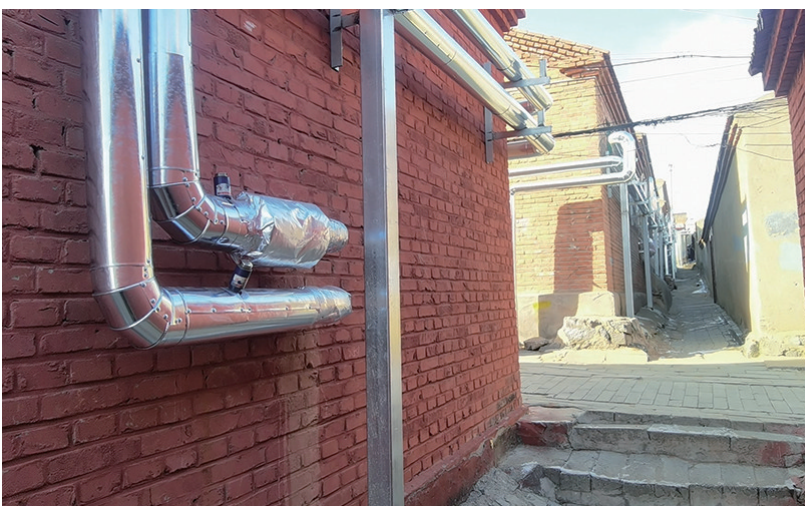
●虎山东路南35号平房区安装全新的集体供暖管道
